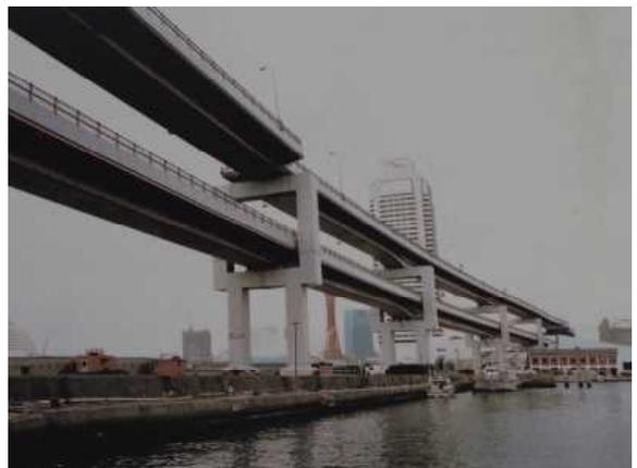
橋桁(はしげた)が横にずれた国道2号浜手バイパス
