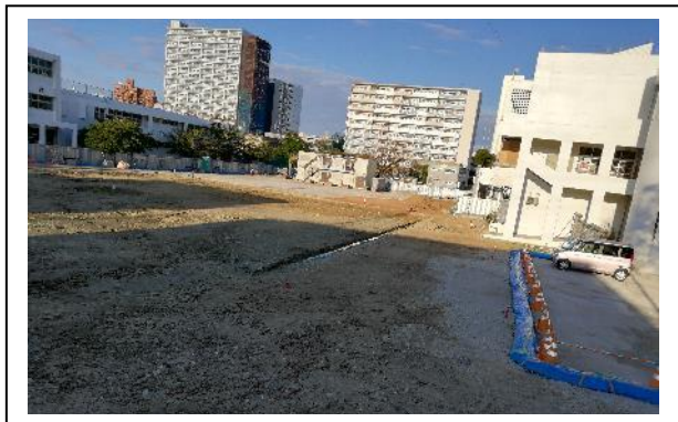
2020年1月5日くい打ちスタート
