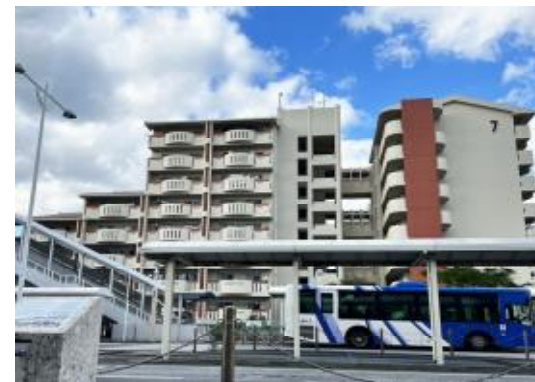
当間学校跡地に建つ県営赤嶺市街地住宅
