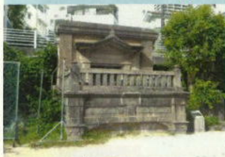
旧校舎の正面玄関2階部分
