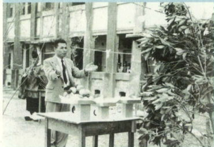
戦災復旧工事の起工式（1955年）
