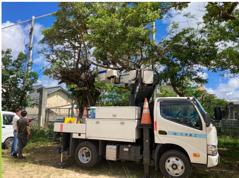
高所作業車を使用しての伐採
